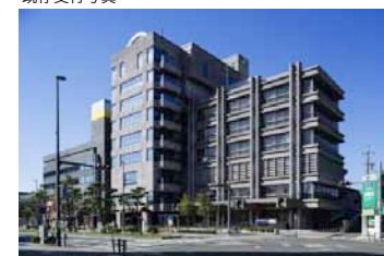
北東側既存建物外観写真
