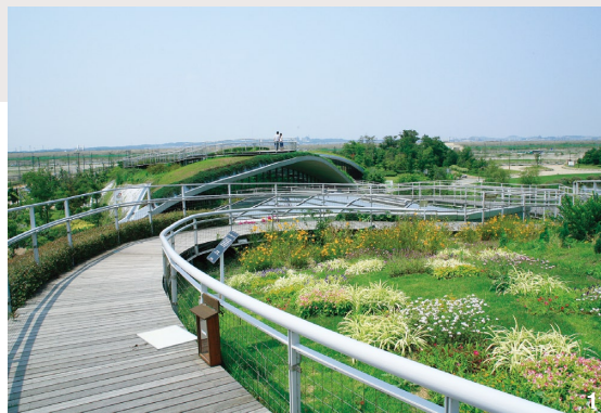
人工島の緑の丘陵は「成長する建築」 【 アイランドシティ中央公園中核施設・ぐりんぐりん 】
