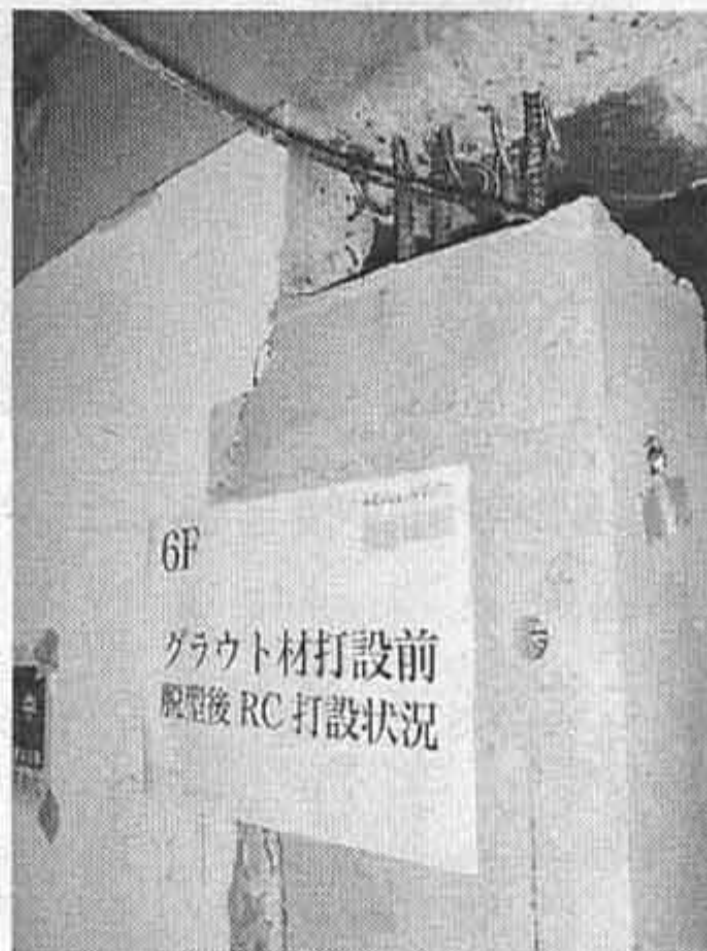
ブレースなどは使わずコンクリートの増し打ちなどで補強する
