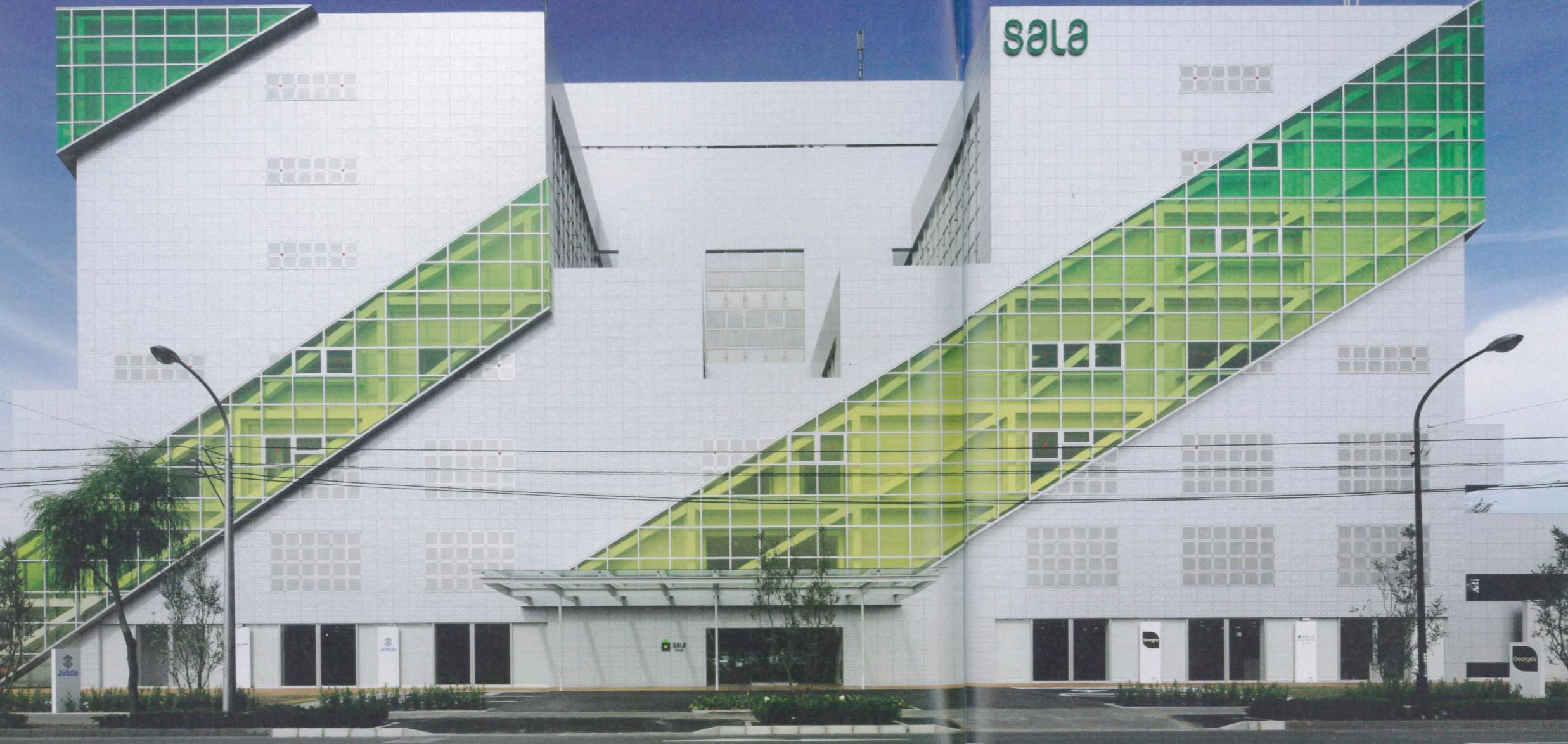
リファイニングされた浜松サーラ南面外観。緑色の帯部分が「スパイラルプレースドベルト補強」（写真撮影：イメージグラム）
